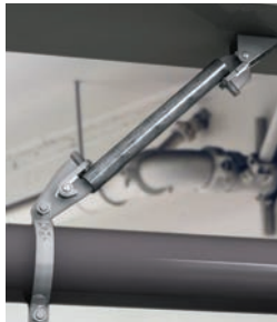
Longitudinal brace
